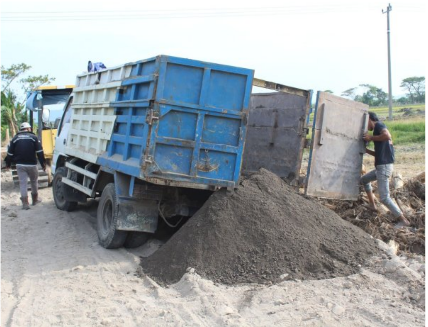
Dropping Material Ke Lokasi TMMD Reg 121 Kodim Klaten
