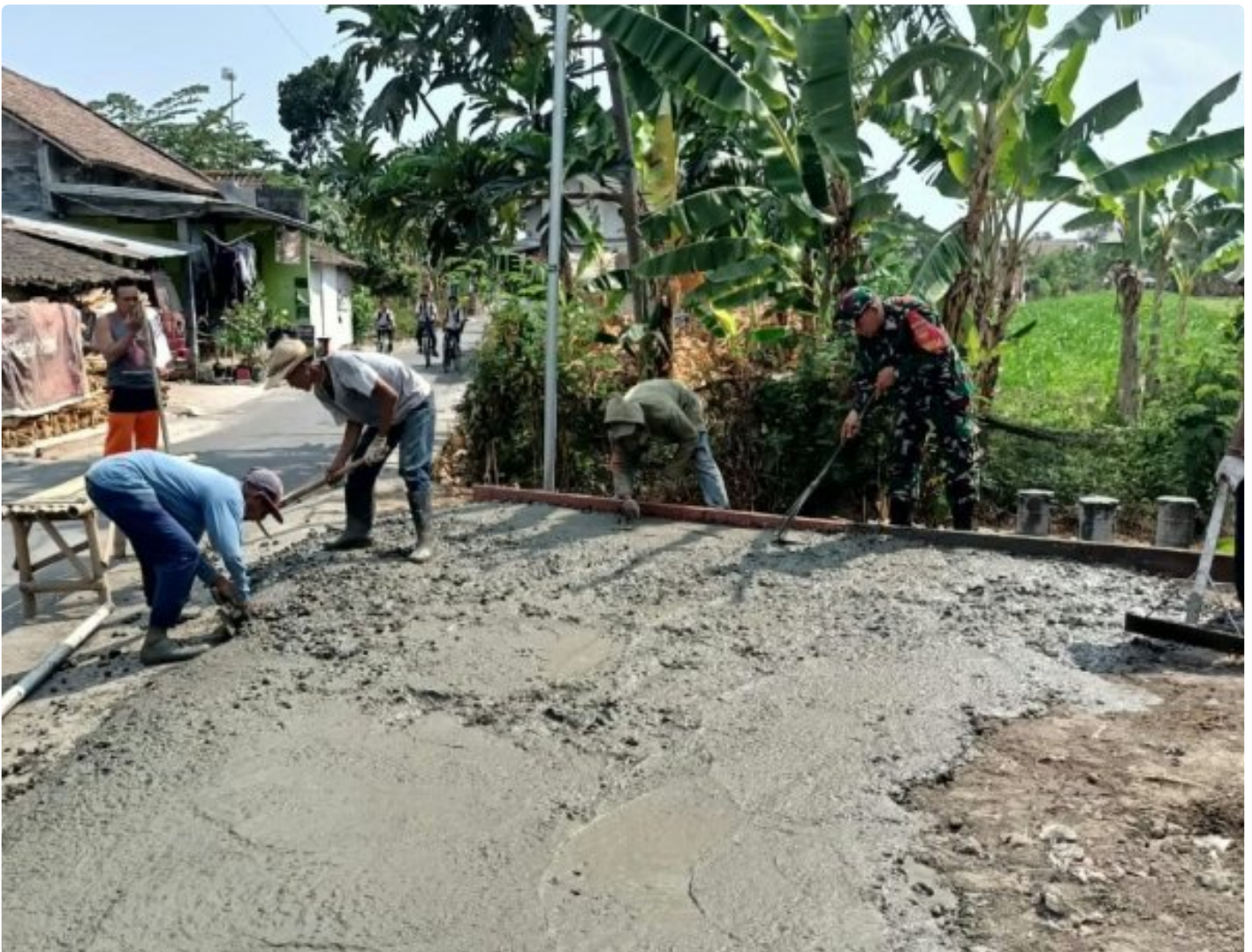
Kemanunggalan TNI Bersama Rakyat, Babinsa Koramil Klaten Utara Gotong Royong Pengecoran Jalan
